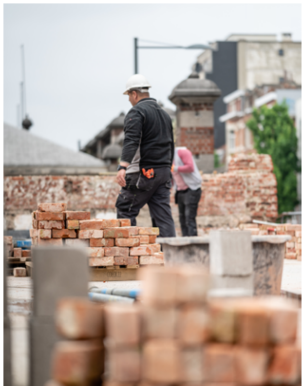
Bakstenen verwijderen - Kazerne van Elsene (BE)
