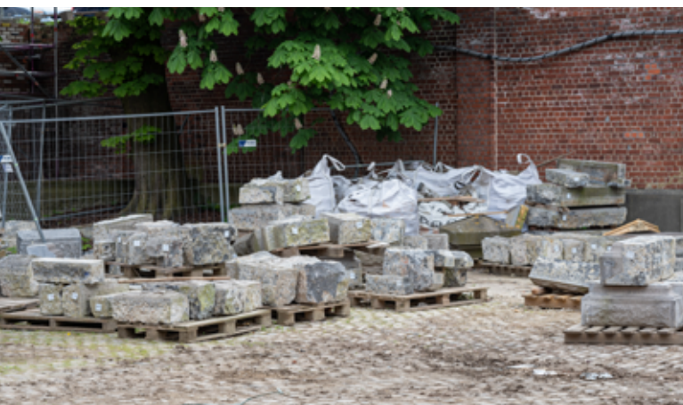
Opslag van verwijderde stenen elementen - Kazerne van Elsene (BE)
