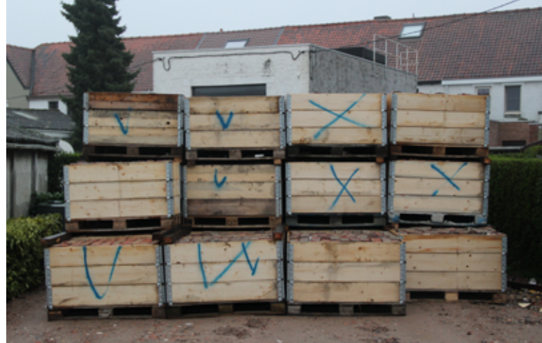
Bakstenen op de bouwplaats gesorteerd in verschillende bakken volgens de naleving van de vereiste criteria – bouwplaats Tuighuisstraat (BE)
