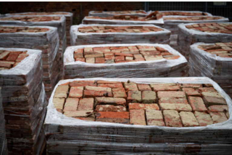
Bakstenen verwijderen - Kazerne van Elsene (BE)
