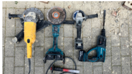
Ontmantelingsproef - MIVB-gebouw (De Boone) in Brussel (BE).
