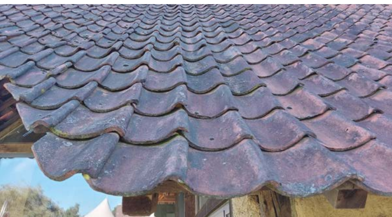
Exemple d'application de tuiles de récupération, illustrant une stabilité dimensionnelle plus faible, avec un impact sur l'esthétique (lignes droites parfois plus difficiles à réaliser)
