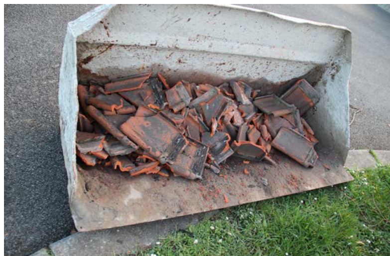
Restes de tuiles non réutilisables triées lors du démontage
