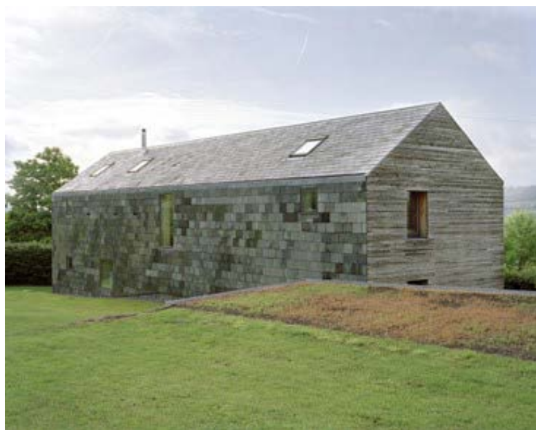
Exemple concret de réemploi de produits de couverture (ardoises naturelles) :
