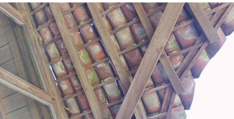
Exemple d'application de tuiles de récupération (tuiles flamandes) sur un bâtiment de 1741 reconstruit au KampC à Westerlo ; remarquez la densité des précipitations réduite de la toiture en raison de la stabilité dimensionnelle plus faible des tuiles ; le rôle de la sous-toiture devient donc très important
