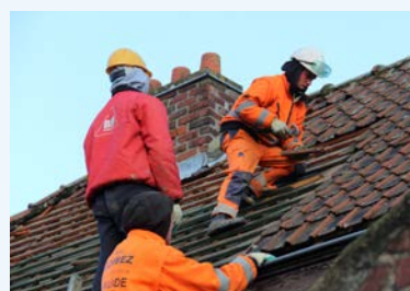
Exemple de soumission des tuiles à un « test acoustique » lors du démontage (© Buildwise, chantier Tuighuisstraat, Courtrai)
