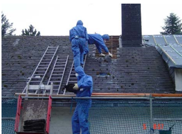
Démantèlement d'un toit revêtu d'ardoises artificielles contenant de l'amiante (© G. Pierrard, 2008)
