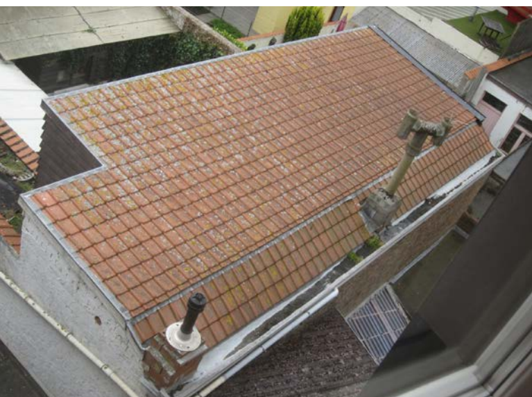
Exemple de formation de lichens sur un versant de toit en pente douce et revêtu de tuiles (note : La pente de ce versant est inférieure à l'inclinaison autorisée pour ce type de couverture) © Buildwise
