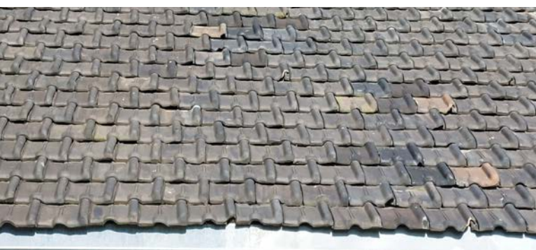
Exemple d'application de tuiles de récupération, illustrant une stabilité dimensionnelle plus faible, avec un impact sur l'esthétique (lignes droites parfois plus difficiles à réaliser)
