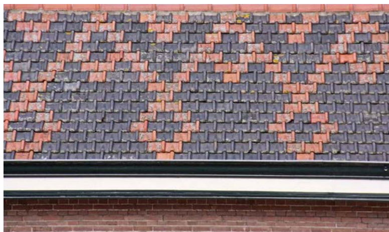
Exemple concret de réemploi de produits de couverture (ardoises naturelles) :
