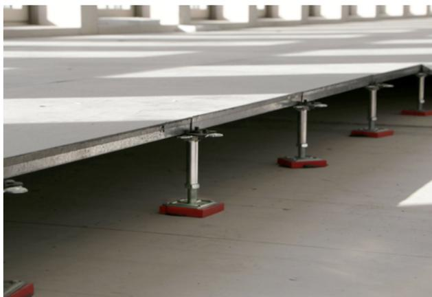
Remise en œuvre de dalles de plancher surélevé de réemploi avec vébins neufs
