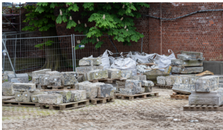
Stockage d'éléments en pierre déposés - Caserne d'Ixelles © Ekkow Photography - Buildwise
