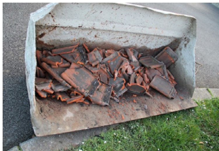
Exemple de tri des restes de tuiles non réutilisables lors du démontage © Buildwise, chantier Tuighuisstraat, Courtrai
