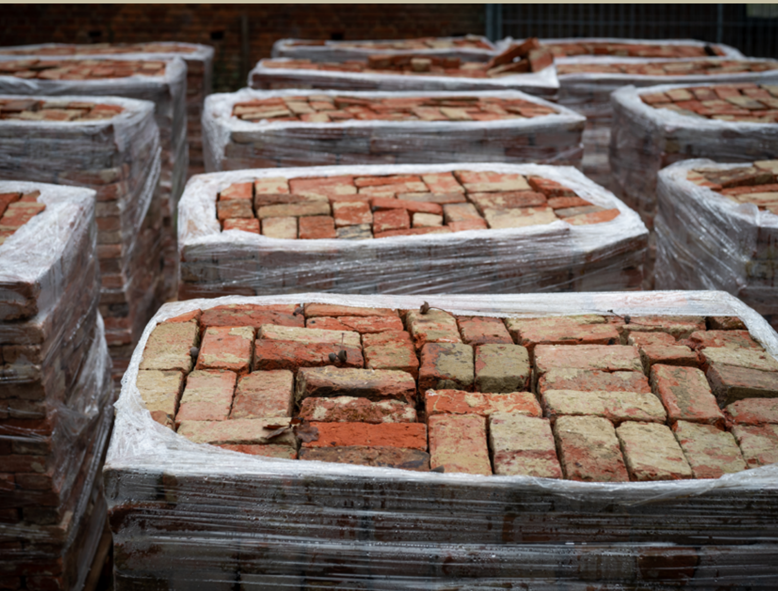
Dépose de briques – Caserne d'Ixelles © Ekkow Photography – Buildwise
