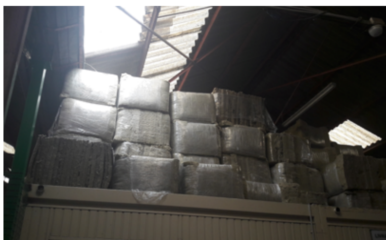
Stockage d'isolants en laine minérale provenant de cloisons intérieures, avant leur remise en œuvre comme isolation de toiture inclinée © Buildwise
