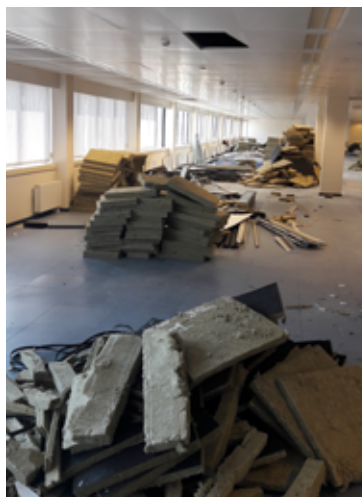
Tri d'isolants en laine minérale provenant de cloisons de séparation internes sur le chantier de l'ONSS à Bruxelles
