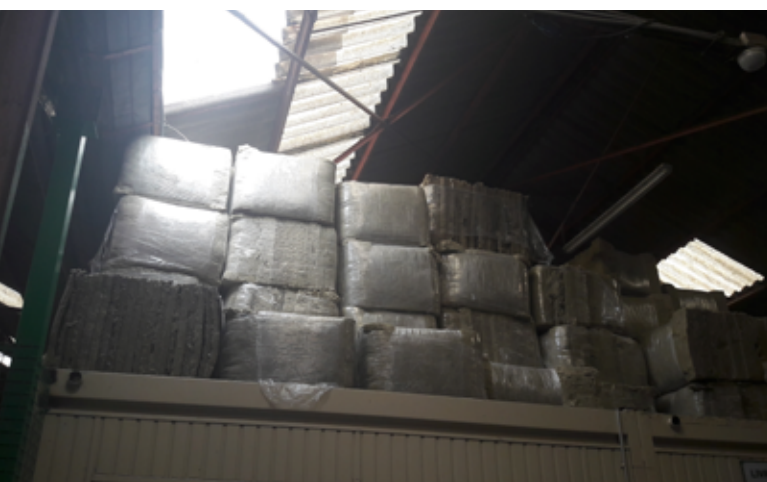
Stockage d'isolants en laine minérale provenant de cloisons intérieures, avant leur remise en œuvre comme isolation de toiture inclinée
