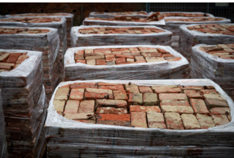
Dépose de briques – Caserne d'Ixelles
