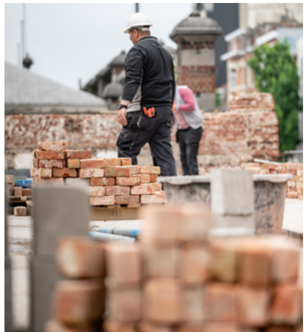
Dépose de briques - Caserne d'Ixelles
