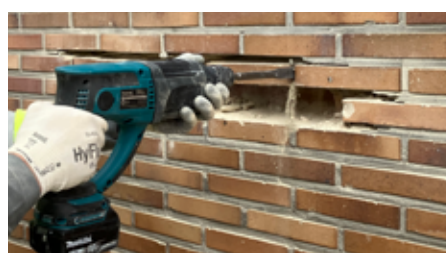
Test de démontage - bâtiment de la STIB à Bruxelles.
