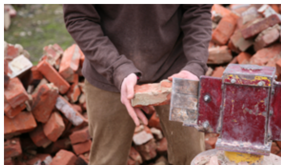
Nettoyage manuel et mécanique des restes de mortier
