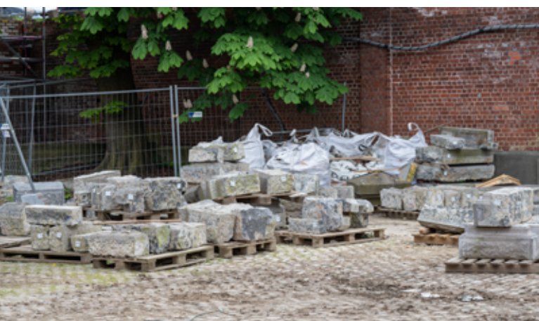
Stockage d'éléments en pierre déposés – Caserne d'Ixelles
