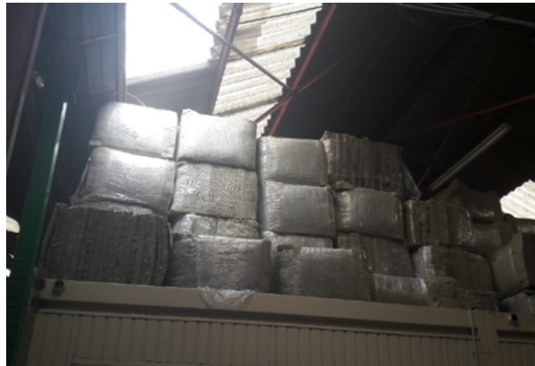
Stockage d'isolants en laine minérale provenant de cloisons intérieures, avant leur remise en œuvre comme isolation de toiture inclinée
