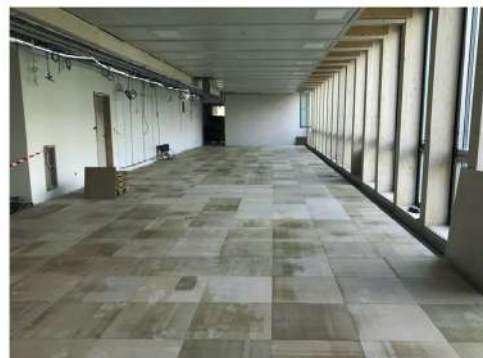
Demontage, verwijdering van tapijttegels, opslag en herinstallatie van verhoogde vloertegels.
