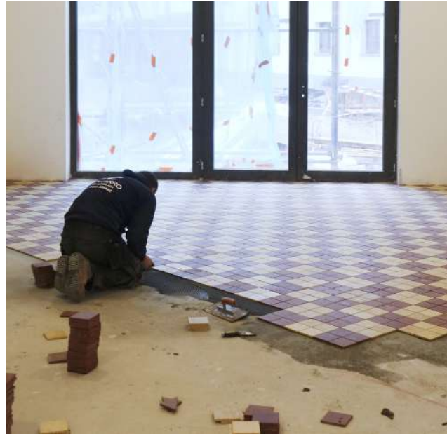
Illustratie van de principes van hergebruik aan de hand van een tegelvloer: zorgvuldige demontage, vervoer, reiniging, verpakking en hermontage.
