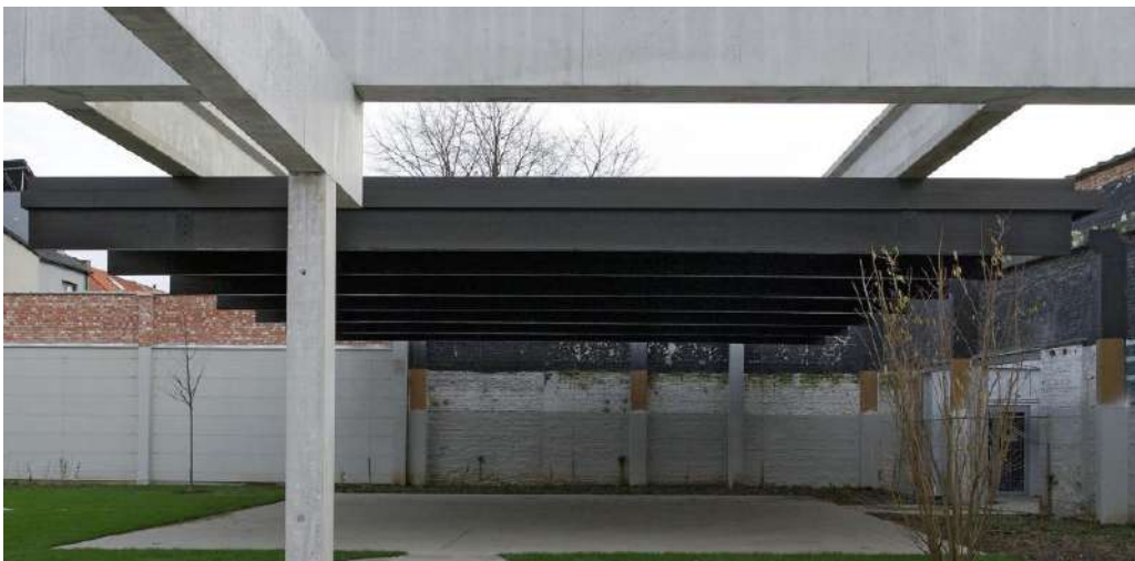
Van boven naar beneden: (1) Oorspronkelijke situatie. (2) Opslag van de balken op de bouwplaats na de demontage. (3) Hergebruik in het nieuwe project.
