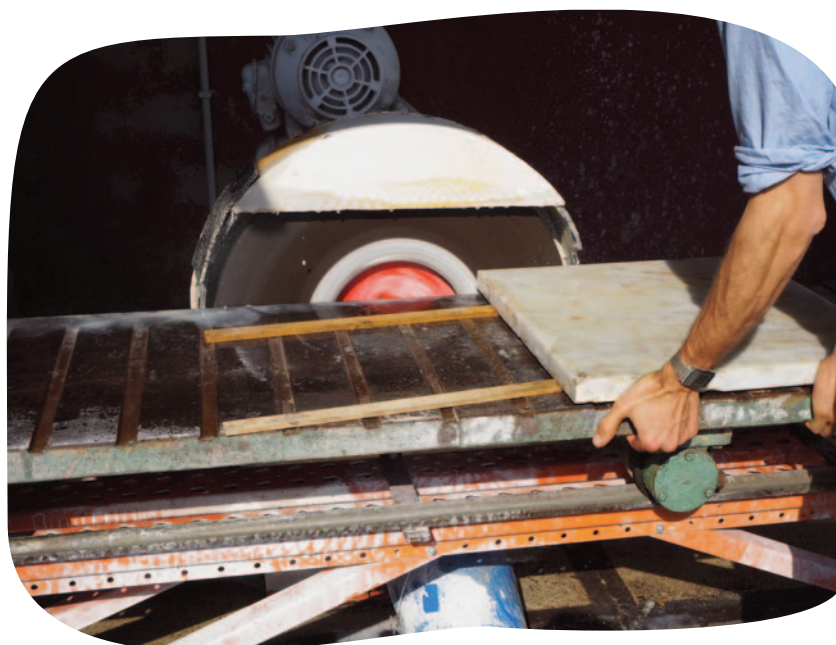
Reiniging van de randen van een marmeren plaat. In dit geval raakt de ingreep niet aan de plaat zelf, maar worden mortelresten van het vorige gebruik verwijderd.
