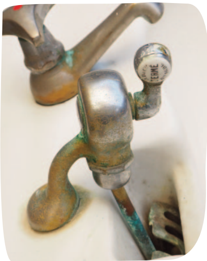
Het chroom van deze spoelbakaccessoires is afgesleten door het gebruik, het onderliggende messing is zichtbaar en heeft ook wat patina gekregen
