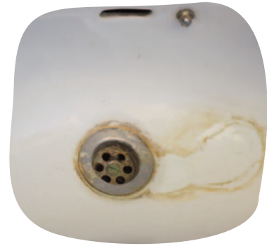
Kalkaanslag op een teruggewonnen gootsteen
