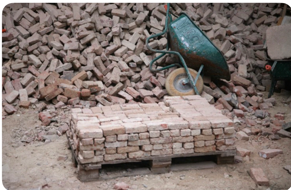
Reinigen en sorteren van gerecupereerde bakstenen
