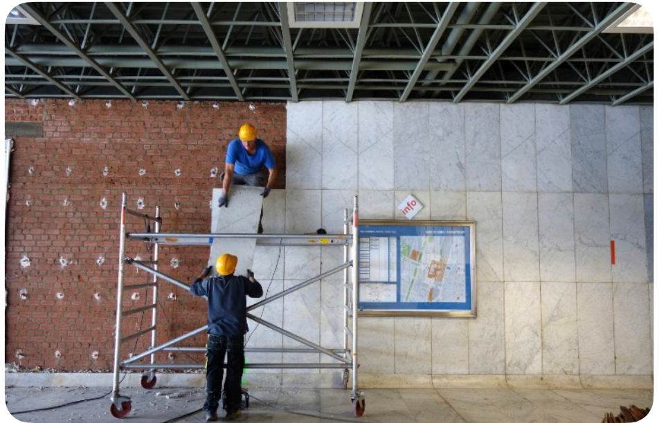
Zorgvuldige demontage van marmeren elementen
