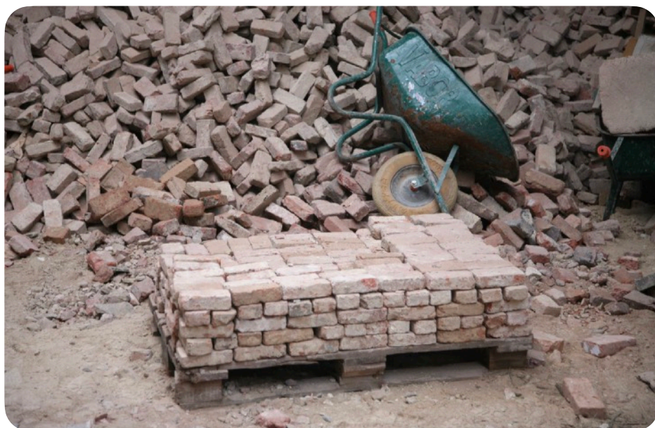
Nettoyage et tri de briques récupérées
