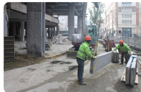
Démontage d'éléments en pierre
