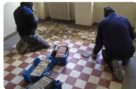
Démontage de carreaux en céramique
