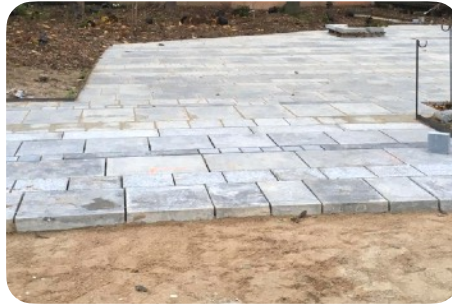
Slabs on sand © Perrine Henault, Atelier NOUS
